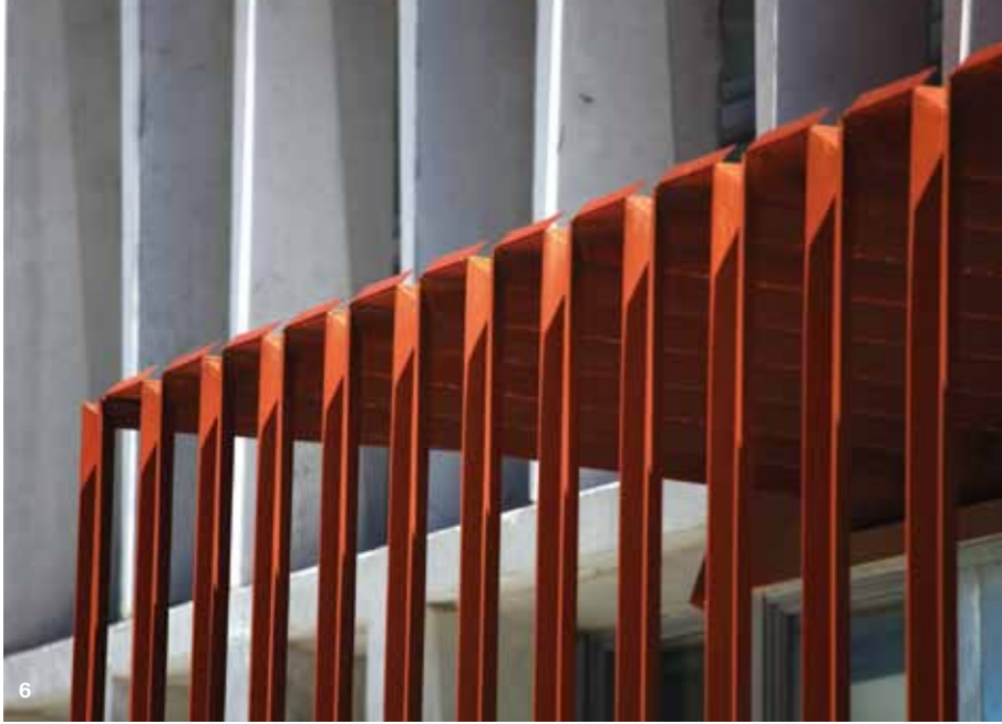
6 入口雨遮及建築外觀 7 入口雨遮及梯廳 8 屋頂欄杆細部 9 中央通廊及樓梯
