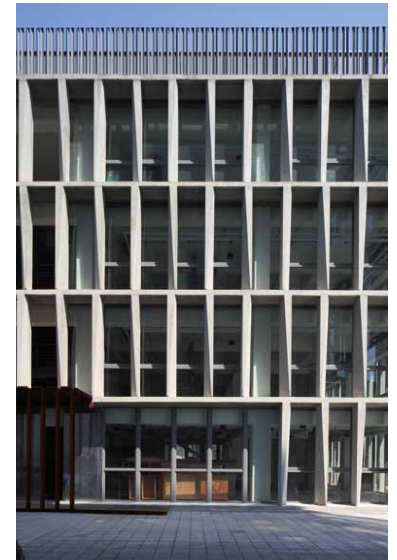
學務大樓建築立面局部
