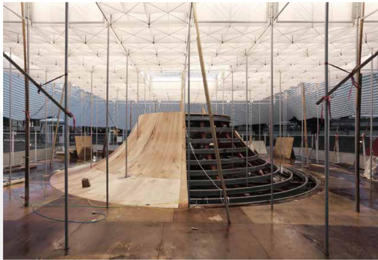
施工中的2016X-site裝置（沈庭增）
