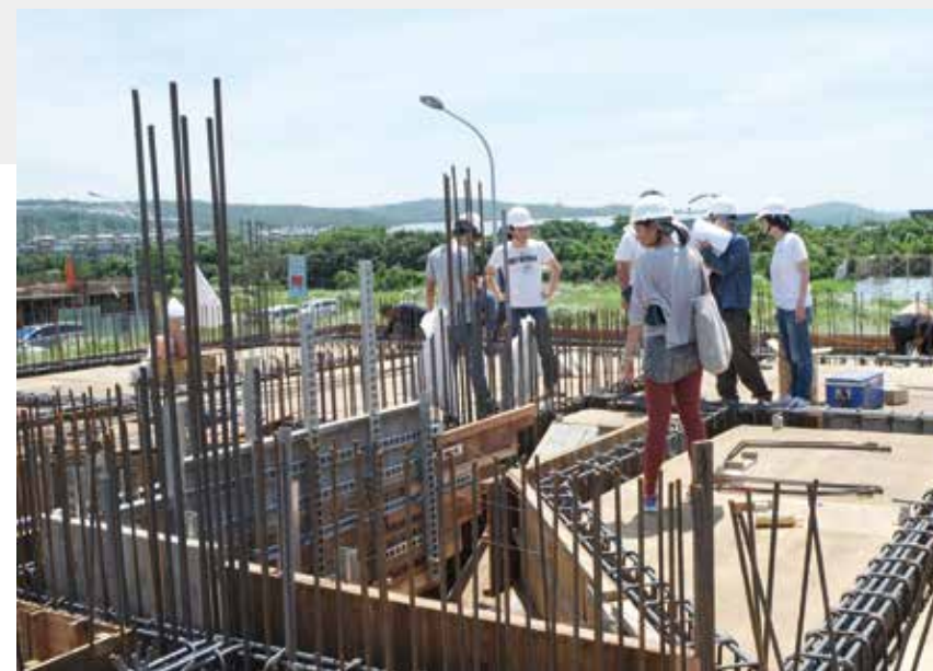
枝光院住宅灌漿前工地討論（沈庭增）
